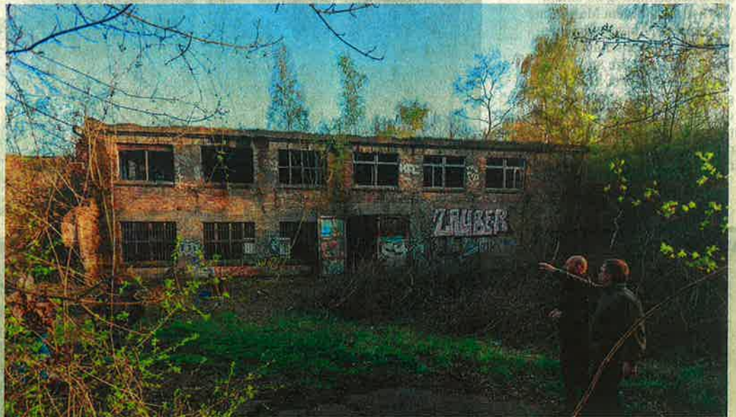
Noch dieses Jahr soll die Sanierung des Maschinenhauses beginnen.
