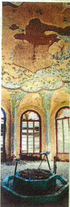
Blick ins noch unsanierte Badehaus
