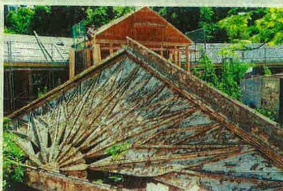
Die Kolonnaden werden aufwendig saniert.
