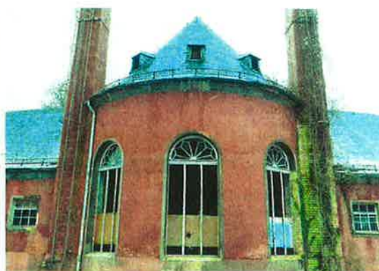
Noch dieses Jahr soll die Sanierung des markanten Badehauses beginnen.
